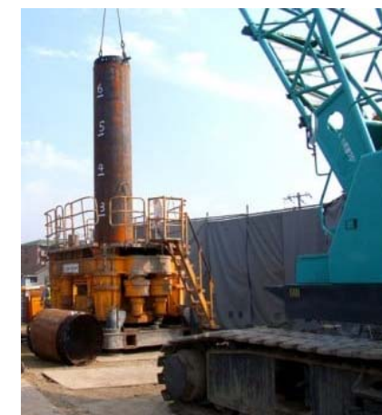
全周回転式オールケーシング工法施工状況写真
