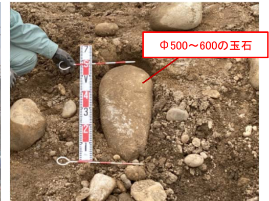
■U型擁壁施工箇所の玉石発現状況
