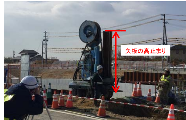
■土留(矢板)の施工不能(高止まり)状況
