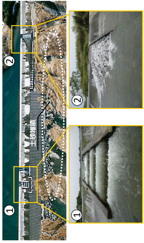
魚道内の水流が激しく、魚の休む場所がない
