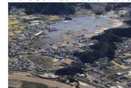
令和元年10月洪水 沼津市大平地区の浸水状況
