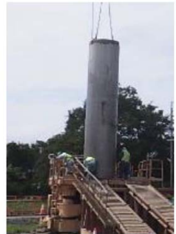
全周回転式オールケーシング工法
