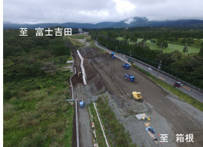
【小山町地内】平成31年4月撮影
