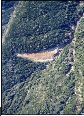
北御所谷の新規崩壊 (H15年4月土石流発生)
