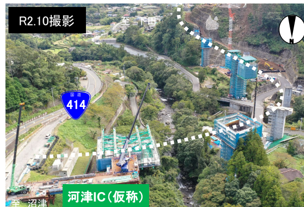
[工事進捗状況:写真①] 河津IC(仮称)付近
