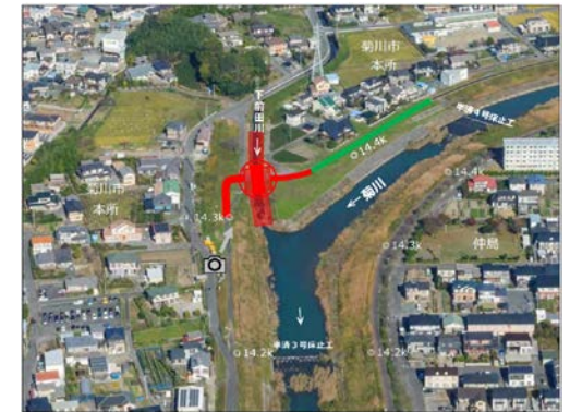
堤防整備箇所
