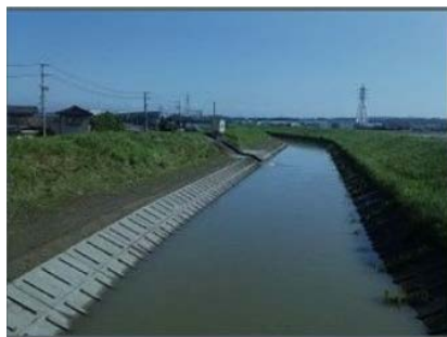
牛淵川 4.0k付近の高水敷土砂掘削
