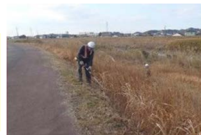
堤防除草作業の様子
