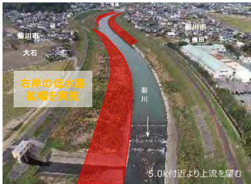
河道掘削予定箇所
