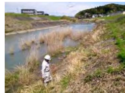
出水後巡視での護岸確認
