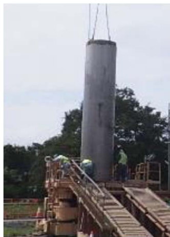
全周回転式オールケーシング工法
