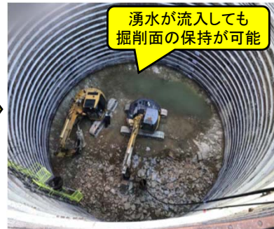
ライナープレートへの変更イメージ (坑壁保持可能)
