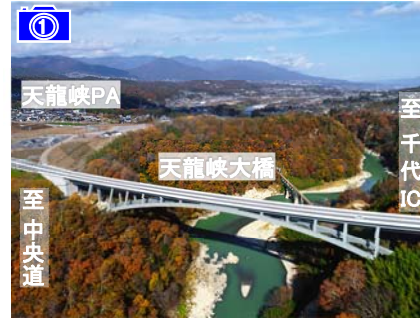
天龍峡大橋(飯田市)
