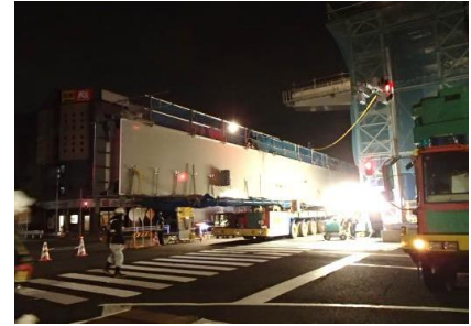
多軸式台車による搬入
