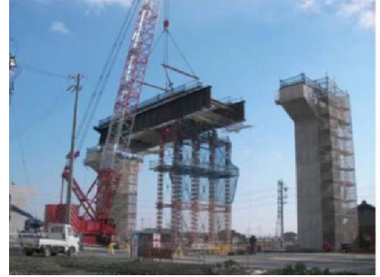
クレーンで仮受けのベントに架設
