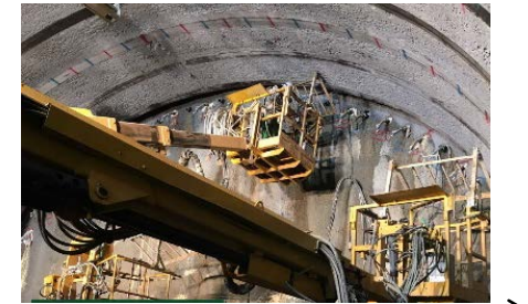
<長尺鋼管フォアホーリング 施工の状況>
