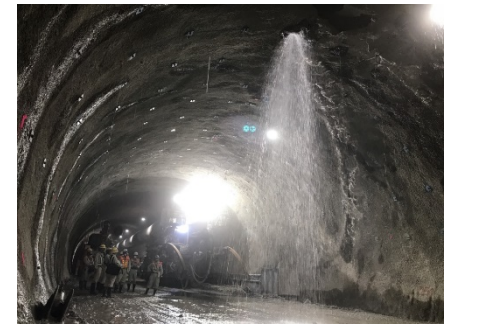
<長尺鋼管フォアホーリング 施工の状況>
