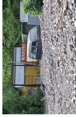
土石流による埋没
