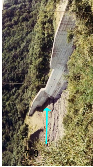
大島砂防堰堤(昭和56年撮影)
