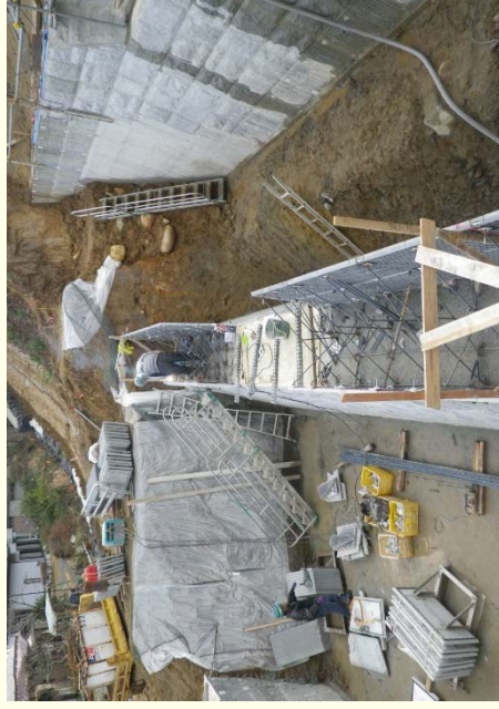
施工時の状況 （鹿群山砂防堰堤）
