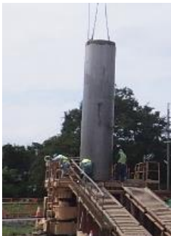
全周回転式オールケーシング工法
