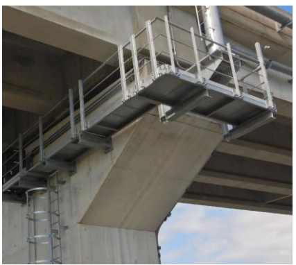
◆下部工検査路設置状況写真 (イメージ)
