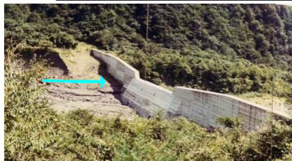
大島砂防堰堤(昭和56年撮影)
