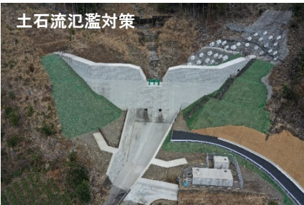
杉の木沢砂防堰堤 (H31年完成)
