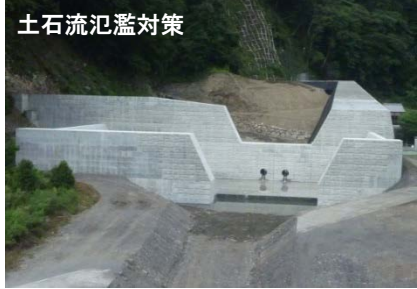
トイグチ沢砂防堰堤 (H25年完成)
