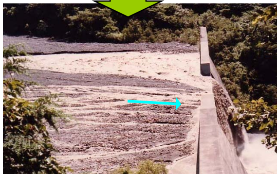
大島砂防堰堤(昭和57年撮影)
