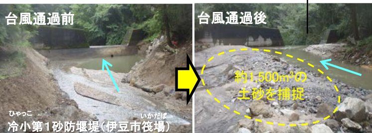
令和元年台風19号に伴う流出土砂の捕捉状況
