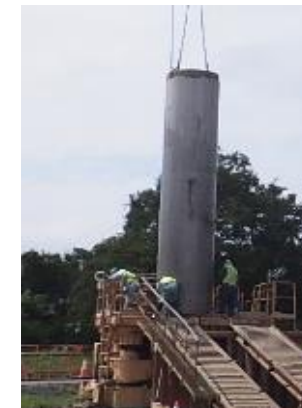
全周回転式オールケーシング工法
