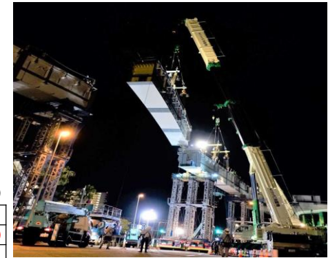
クレーンで仮受けのベントに架設
