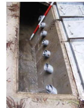
横ボーリング工
