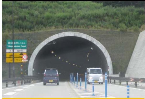
写真③ 高山国府トンネル
