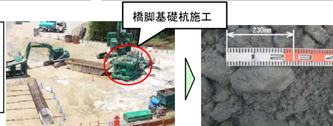
杭施工時に玉石を確認
