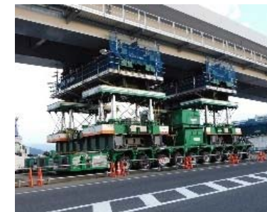
多軸式台車による架設
