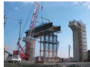
クレーンで仮受けのベントに架設
