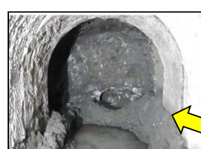
泥濘化した掘削岩(トンネル切羽部の状況)
