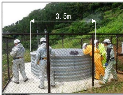
おおくぼ 深さ：17~61m [写真-1] 集水井工施設と点検状況（大久保集水井工）
