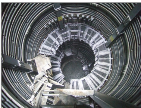
おおくぼ 深さ：17~61m [写真-1] 集水井工施設と点検状況（大久保集水井工）
