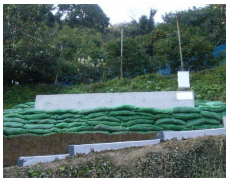
集水管径 φ40mm 集水管長：40~80m やまなか [写真-2] 横ボーリング工施設と排水状況（山中ブロック）
