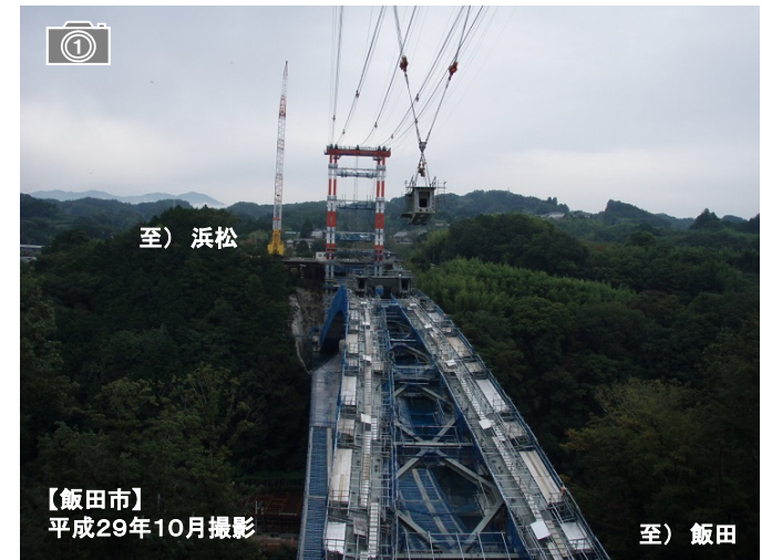
天龍峡大橋の工事進捗状況
