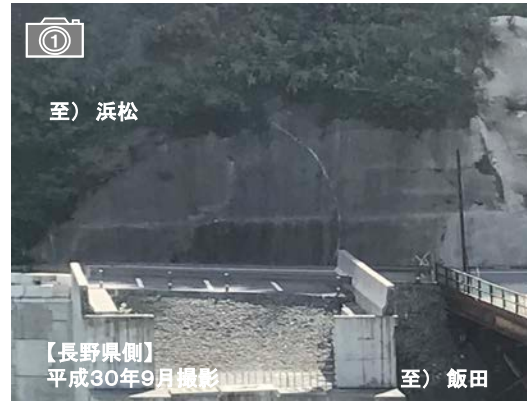
<本坑(長野県側)>
