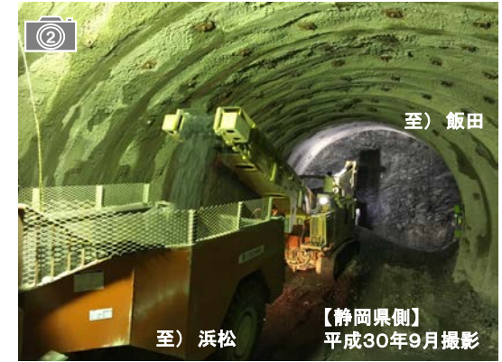
<調査坑(静岡県側)>
