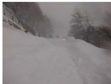
写真② H26.2 大雪による雪崩発生 約27時間全面通行止め
