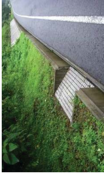
這い出し用スロップ付き側溝の設置
