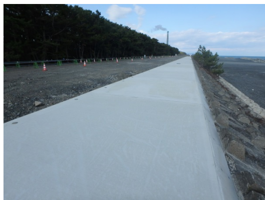
【粘り強い堤防[焼津工区](H31.3)】
