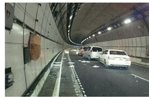
中央自動車道 事故による通行止め (H30.12.7)
