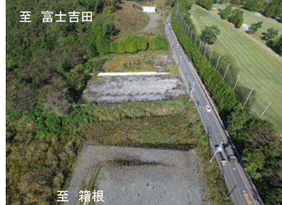
【小山町地内】平成29年3月撮影
