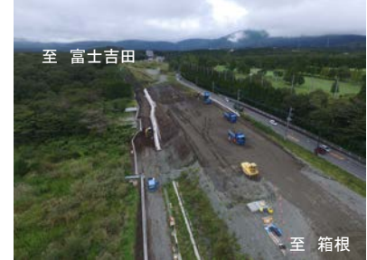
【小山町地内】平成31年4月撮影
