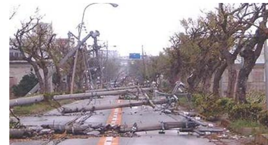
被災イメージ（写真は沖縄県宮古島） 電柱が倒壊し、緊急車両の通行に支障となる
