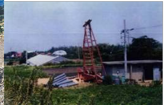
応急井戸掘りの様子 (平成6年)
