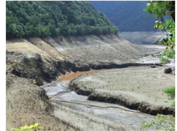
枯渇する宇連ダム (平成25年9月)
