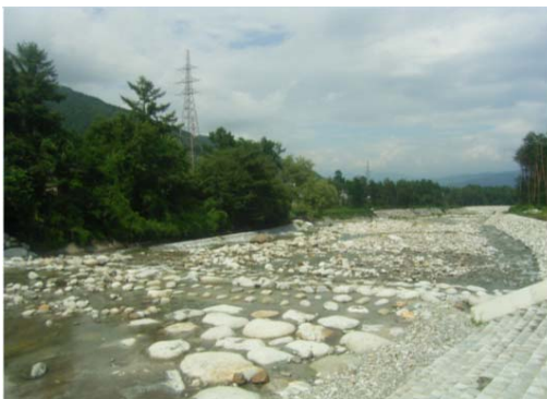
おたぎりとこがためこうぐん だい16ことがためこう 太田切床固工群 第16床固工 (H25年度完成)(太田切川流域)
