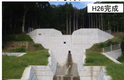
峰ノ平沢砂防堰堤
