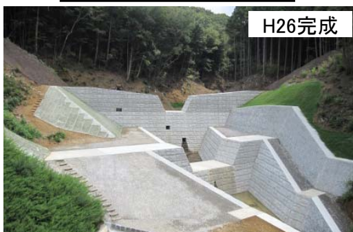
小豆沢砂防堰堤
