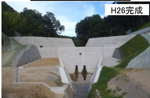
長沢川砂防堰堤
