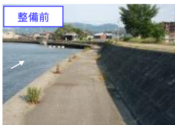
周辺環境に配慮されず、利用されにくかった
