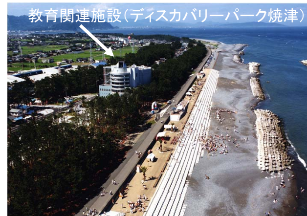
教育施設と一体で整備した海岸堤防(焼津工区)
