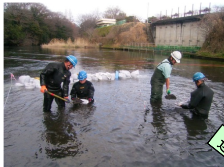
柿田川での土砂掘削
