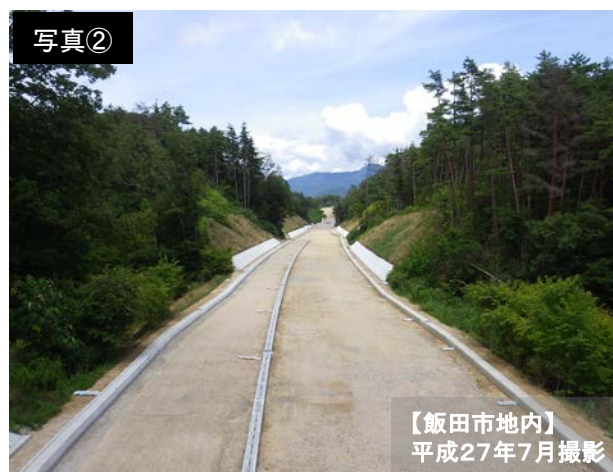
工事進捗状況(改良工事)
