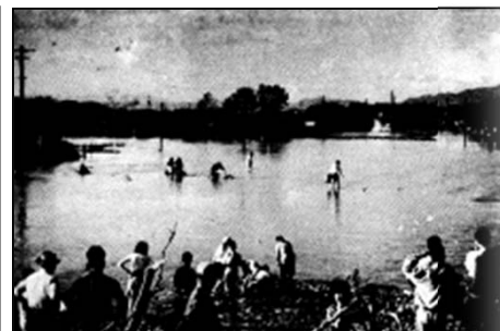
台風13号で堤防決壊により浸水した津市
