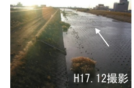
（ヨシ原創出前の豊川放水路）
