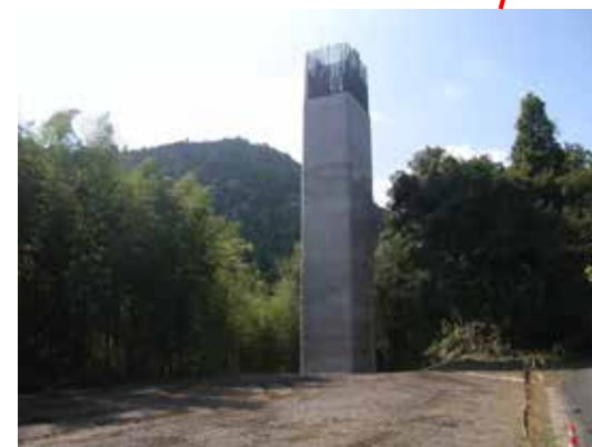
新小和沢橋橋脚完成状況
