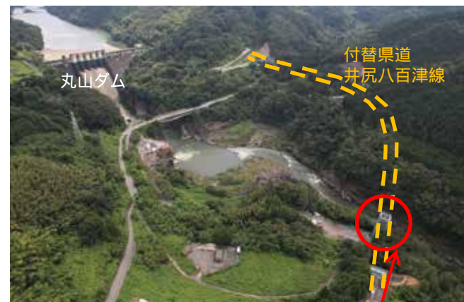
工事箇所全景
