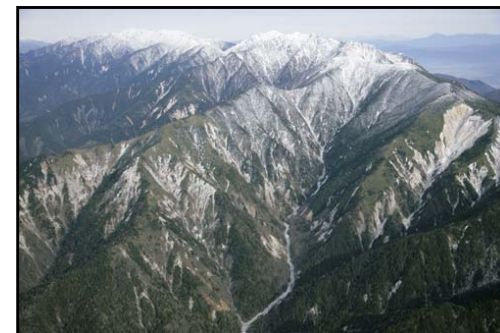
伊奈川上流の崩壊状況
