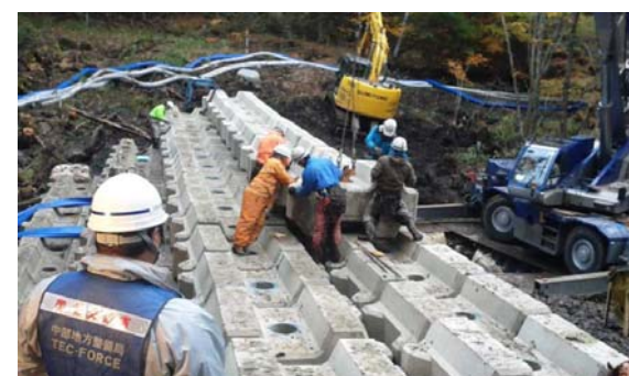
鹿ノ瀬川ブロック積み堰堤設置状況
