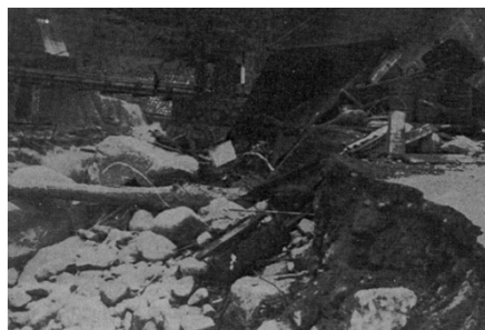
川上地区の被災状況
