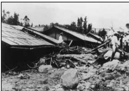
中津川市内の被災状況
