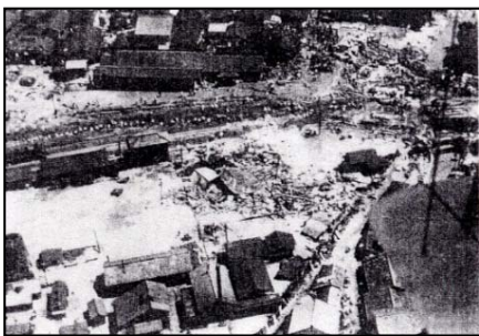
中津川市内の被災状況
