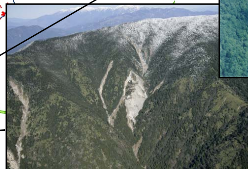
中津川支川一の沢の崩壊状況
