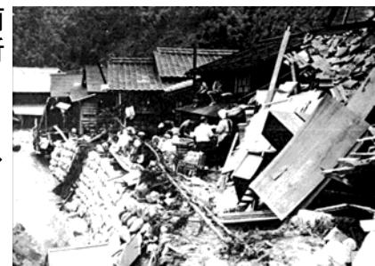
土石流に破壊された人家
