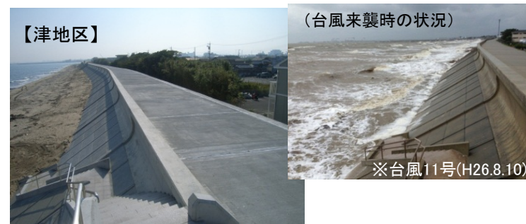
整備後の堤防
