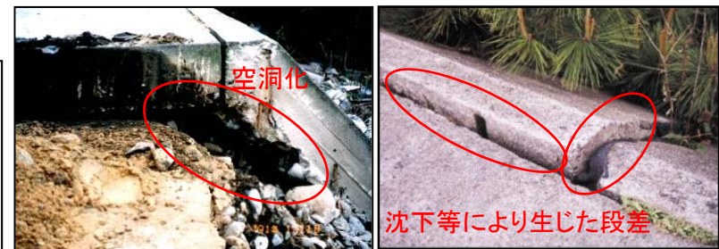
空洞化や地盤沈下等により機能低下した堤防の例(津地区)
