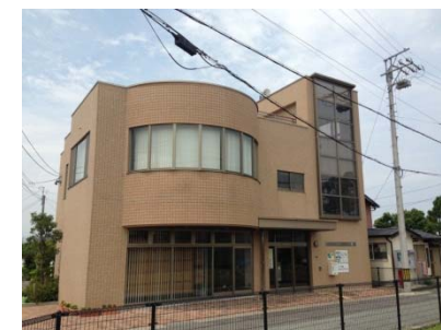
賛岐地区防災コミュニティセンター(文教施設)
