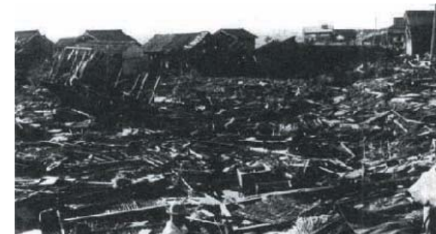
台風13号で被災した家屋（松阪市）
