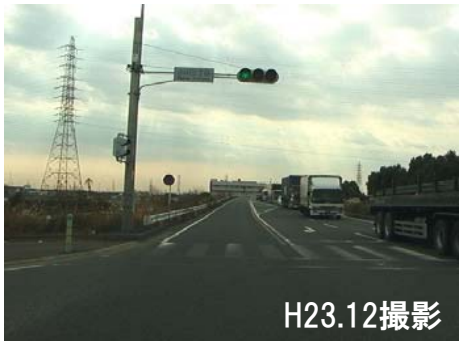
【小川高架橋下部工(上り)の状況【写真①】】
