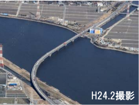
【飛島大橋の状況【写真②】】
