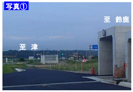
【鈴鹿市地内】平成26年8月撮影 交差点立体化工事
