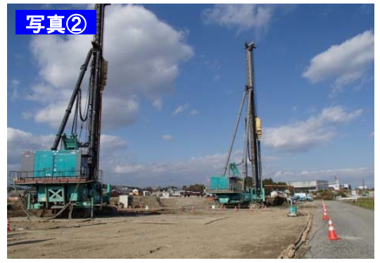
【鈴鹿市地内】平成25年11月撮影 地盤改良工事
