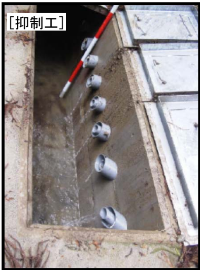
横ボーリング工による排水の状況
