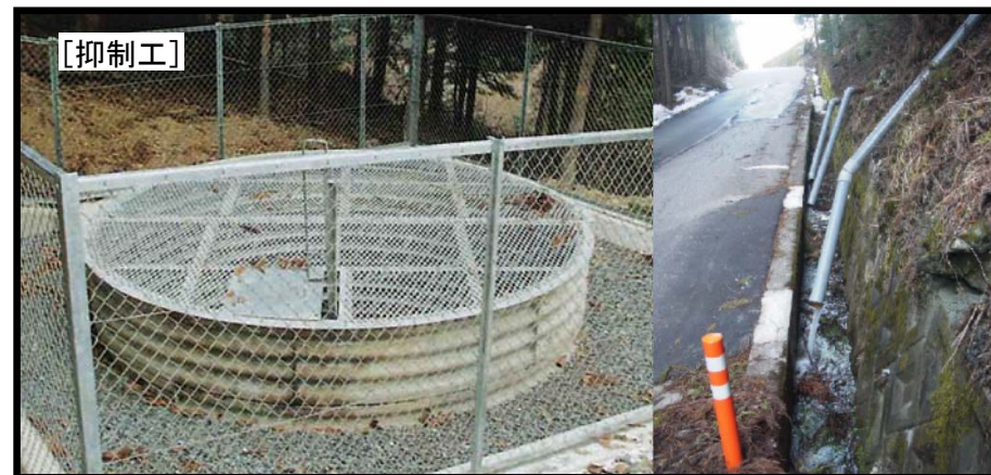
集水井工全景及び集水井からの排水状況
