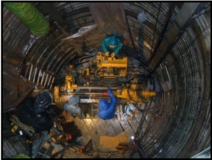
集水井工施工状況(Aブロック)
