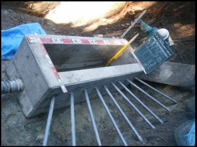
横ボーリング工施工状況(Bブロック)
