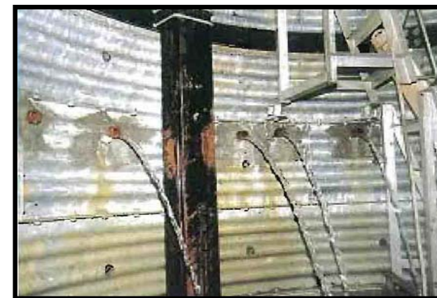
集水井工全景及び内部の集水状況
