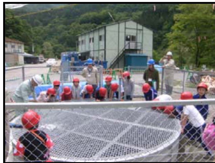
大鹿小学校による工事見学会
