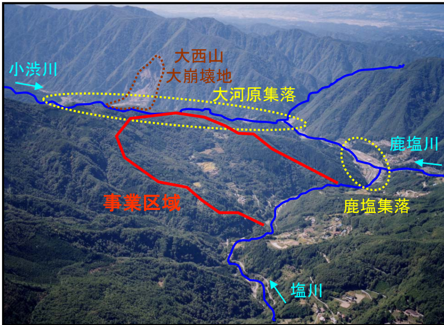
入谷地区地すべりの状況
