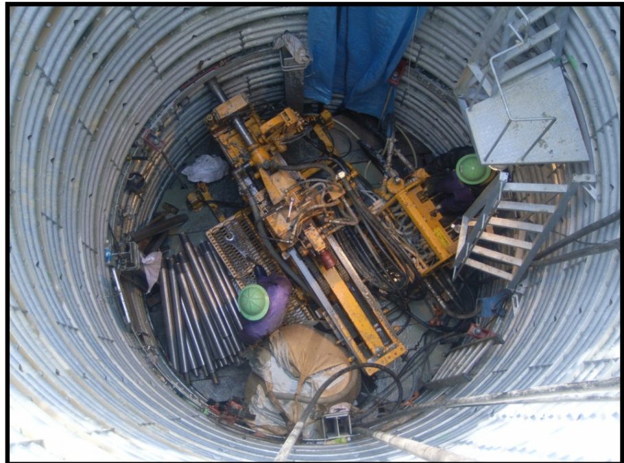
集水井工施工状況（Gブロック）
