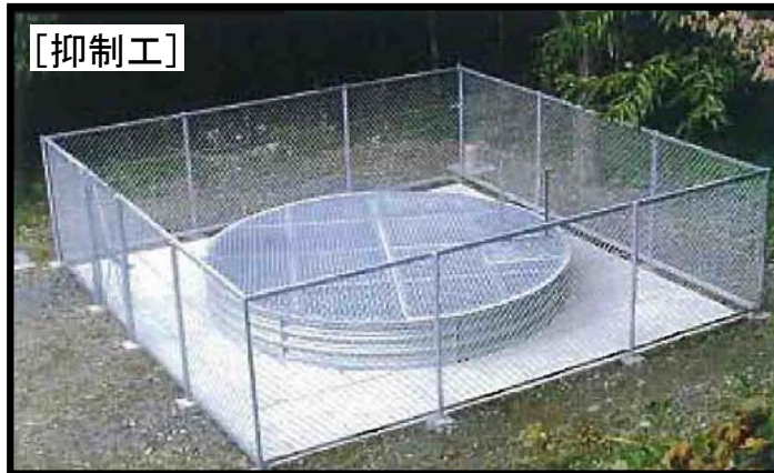
集水井工全景及び内部の集水状況
