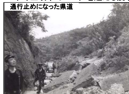
通行止めになった県道
