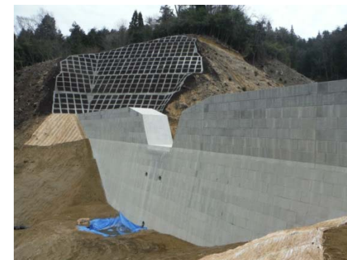
げんしん 源新川砂防堰堤
