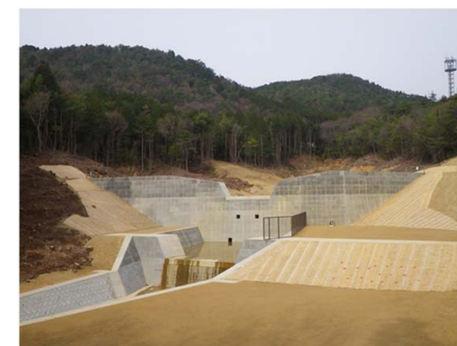
大沢砂防堰堤
