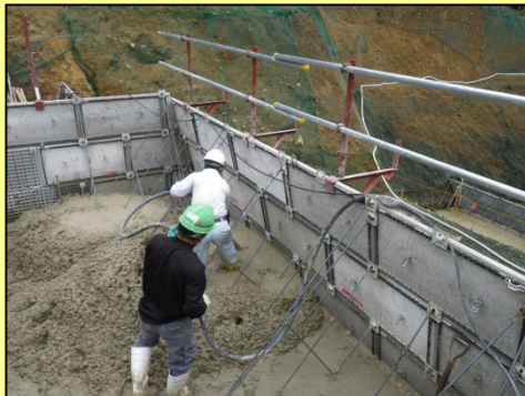
残存型枠を利用した整備
