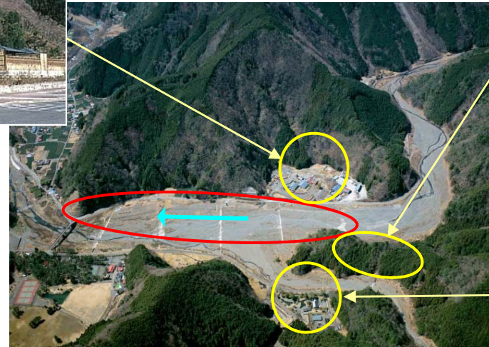
三河内川床固工群
