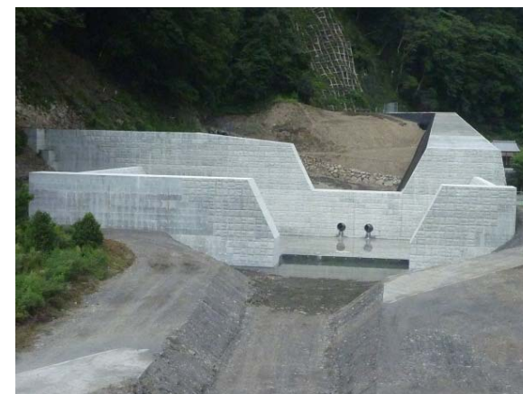
トイグチ沢砂防堰堤(H25年完成)
