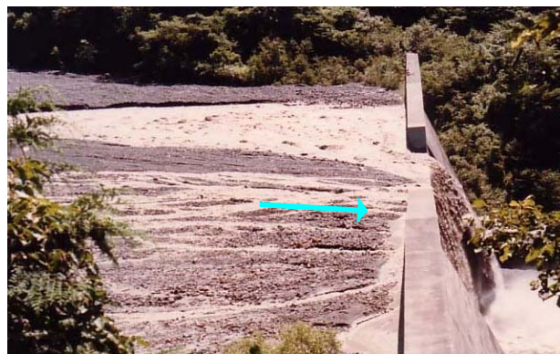
大島砂防堰堤(昭和57年撮影)
