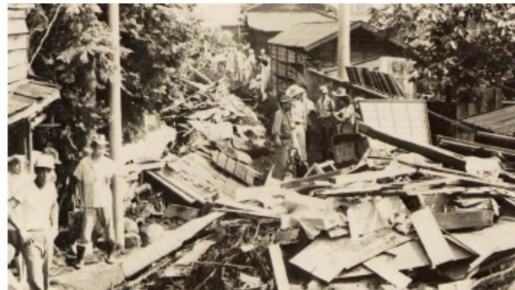
②富士市富士岡地区の被災状況
