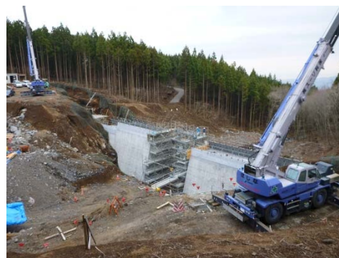
風祭上流砂防堰堤工群(施工中)
