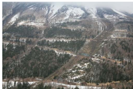
④富士山スカイライン被災状況
