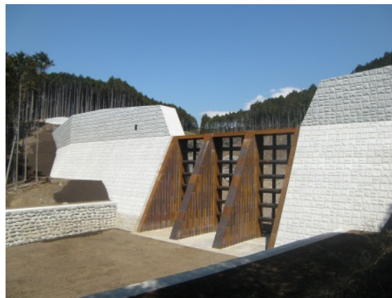
千束第5堰堤 (H25年完成)
