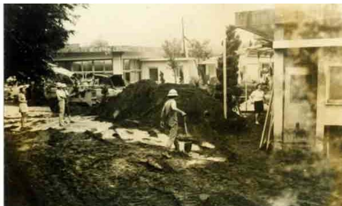
①富士宮市上井出地区の被災状況
