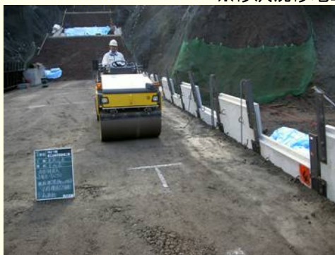
転圧・締固め
