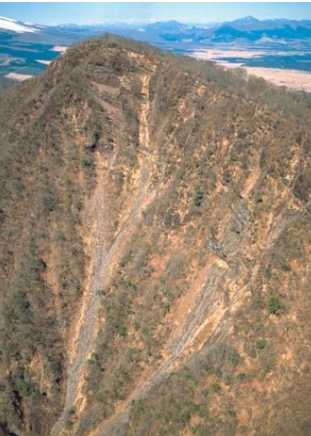
須津川上流荒廃状況
