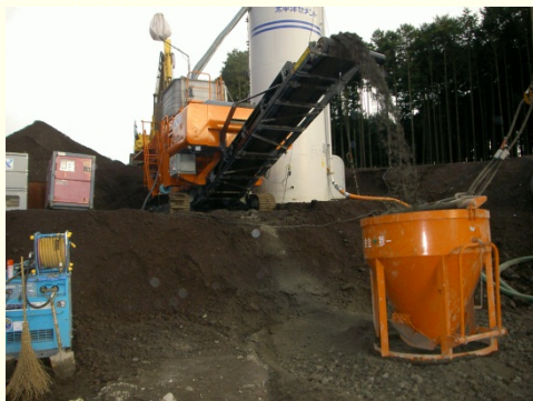
土砂とセメントの混合
