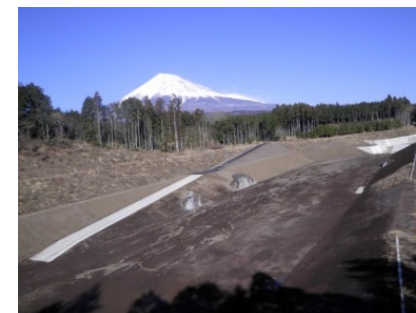
砂沢沈砂池工 (H24年完成)
