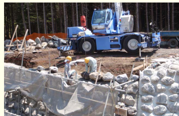
巨石張り護岸施工状況
