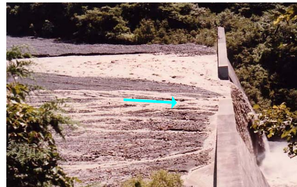
安倍川大島砂防堰堤(昭和57年撮影)
