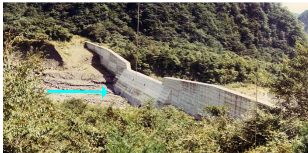
安倍川大島砂防堰堤(昭和56年撮影)
