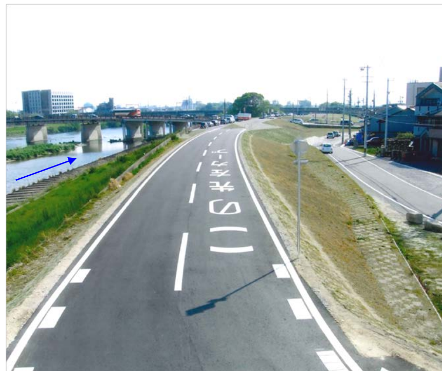
築堤状況 (右岸県道枇杷島橋上流)
