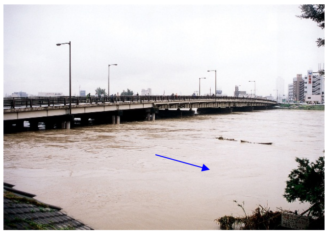
東海豪雨時の状況 (県道枇杷島橋)
