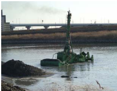
水中ブル掘削状況(岩塚地区) (H25年度完成)
