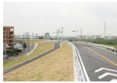
堤防整備(岩塚地区)の事例
