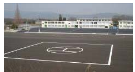
広域防災拠点
